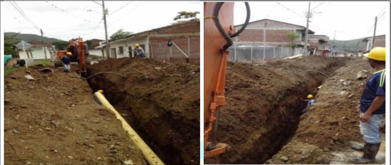
**EXCAVACIÓN PARA INSTALACIÓN DE TUBERIA PVC SANITARIA**
